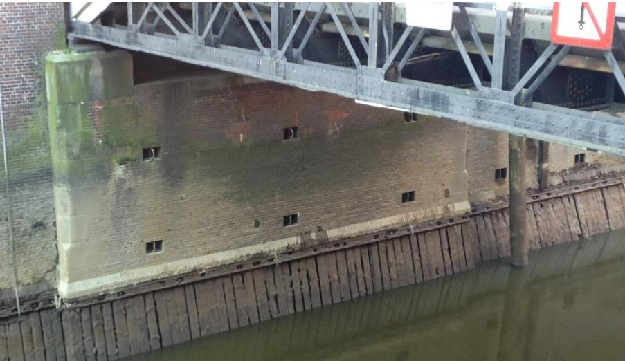
Abb. 3: Holländischfleet-Widerlager Südseite mit freigelegter Holzspundwand
