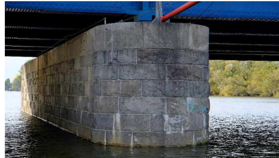
Abb. 4: Süderelbrücke-Flusspfeiler 2 mit Blick Richtung Westen
