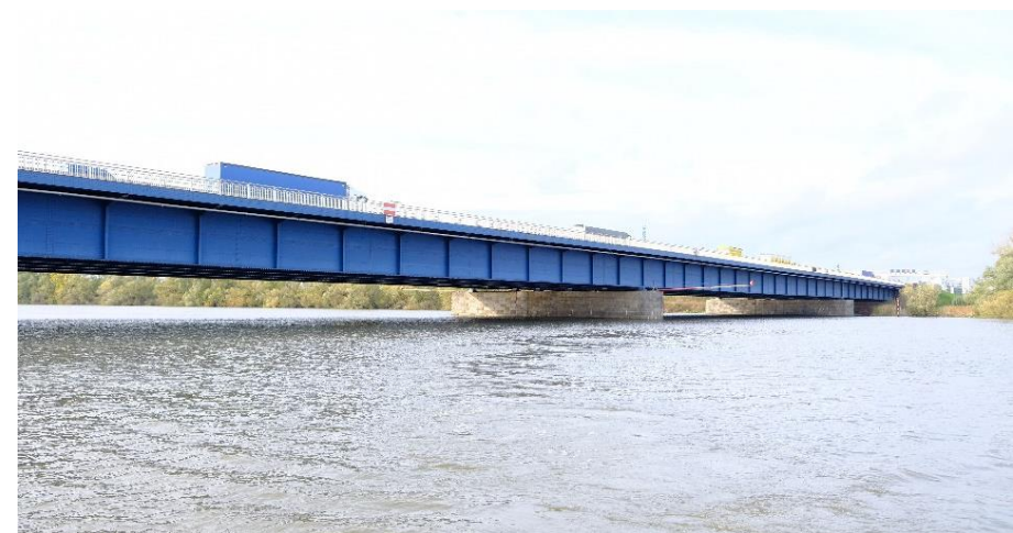
Abb. 2: Süderelbbrücke BAB 1, Hamburg
