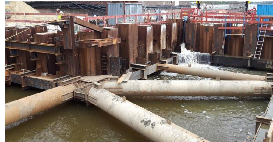
Abb. 1: \geq 25 m tiefe Baugrube der Torkammer mit Steifen
